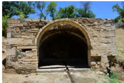
Şekil 10: Güney girişi ön cephesi.
